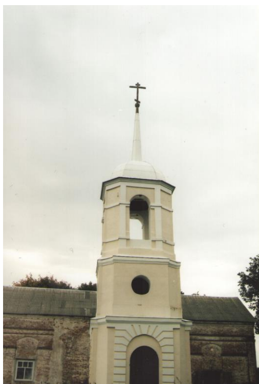
Колокольня с. Усох. После реставрации.
