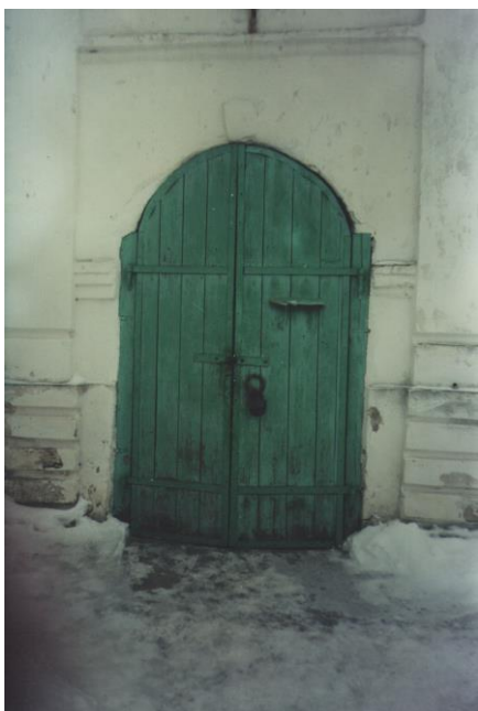
Паперть (фото до ремонта)
